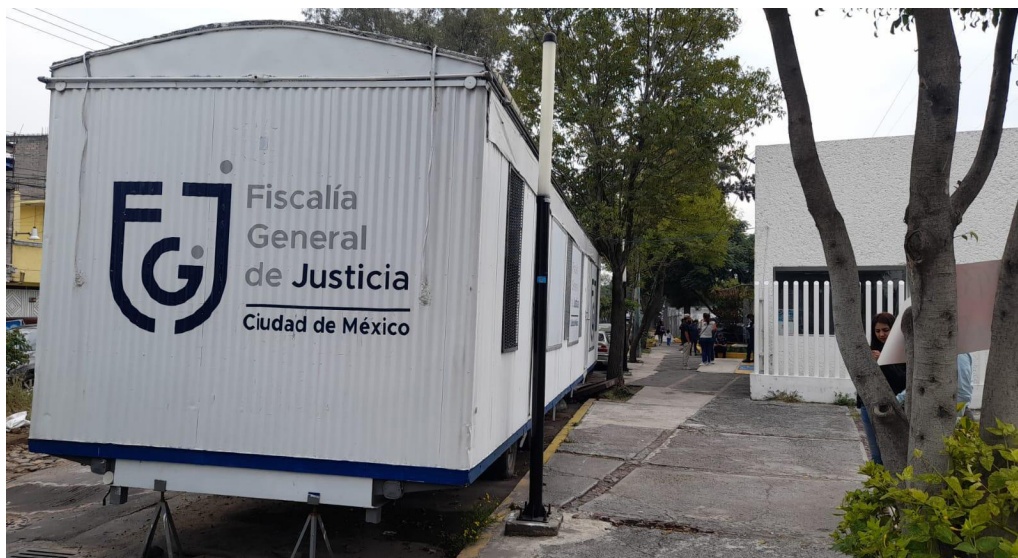
FOTO 4. Contenedor adaptado provisionalmente para la operación de la UCP Oriente
